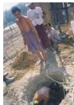
↑トイレを掘る様子
