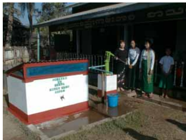
完成した井戸を視察
