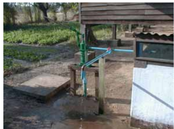
提供した井戸の手動式ポンプ
