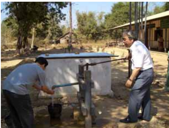
提供した井戸から冷たいきれいな水が出る
